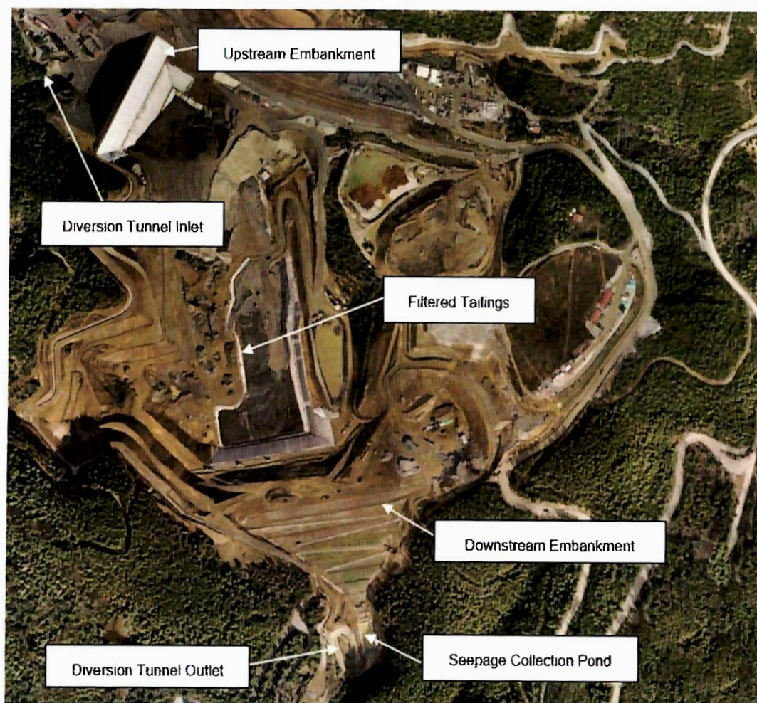
Σχήμα 5-6: Φωτογραφία (κάτοψη) της ΕΔΕΑ Κοκκινόλακκα
