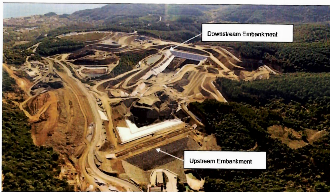
Σχήμα 5-1: Φωτογραφία της ΕΔΕΑ Κοκκινόλακκα κατά την κατασκευή (νοτιοανατολικός προσανατολισμός)
