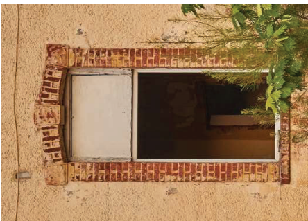
Περιμετρικό πλαίσιο παραθύρων με τουβλάκι και τοξωτό υπέρθυρο
