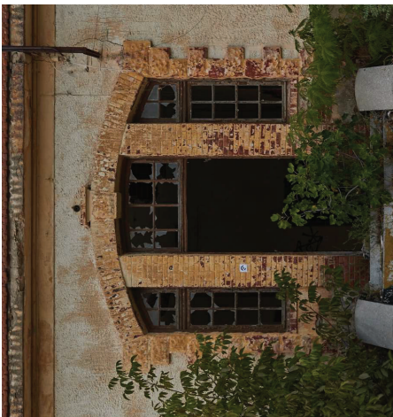
Τοξωτό πλαίσιο θύρας με συνδυασμό από ασβεστοποιημένο νάμα σε απομίμηση πέτρας και τουβλάκι
