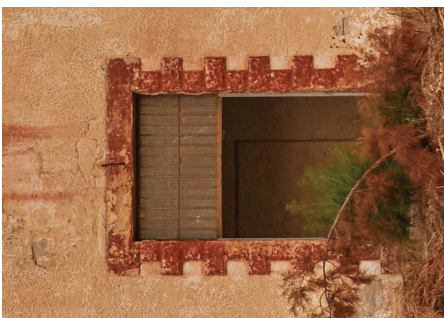
Πλαίσιο θύρας με ασβεστοποιημένο νάμα σε απομίμηση πέτρας
